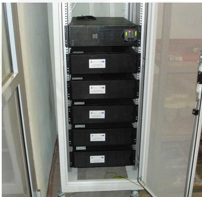
Rys. 7. Zasilacz rezerwowy UPS zasilający serwery projektu z bateriami akumulatorów
