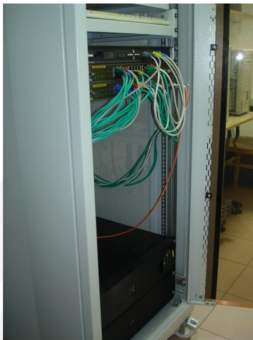
Rys. 8. Router wykorzystywany w projekcie oraz zasilacz rezerwowy UPS
